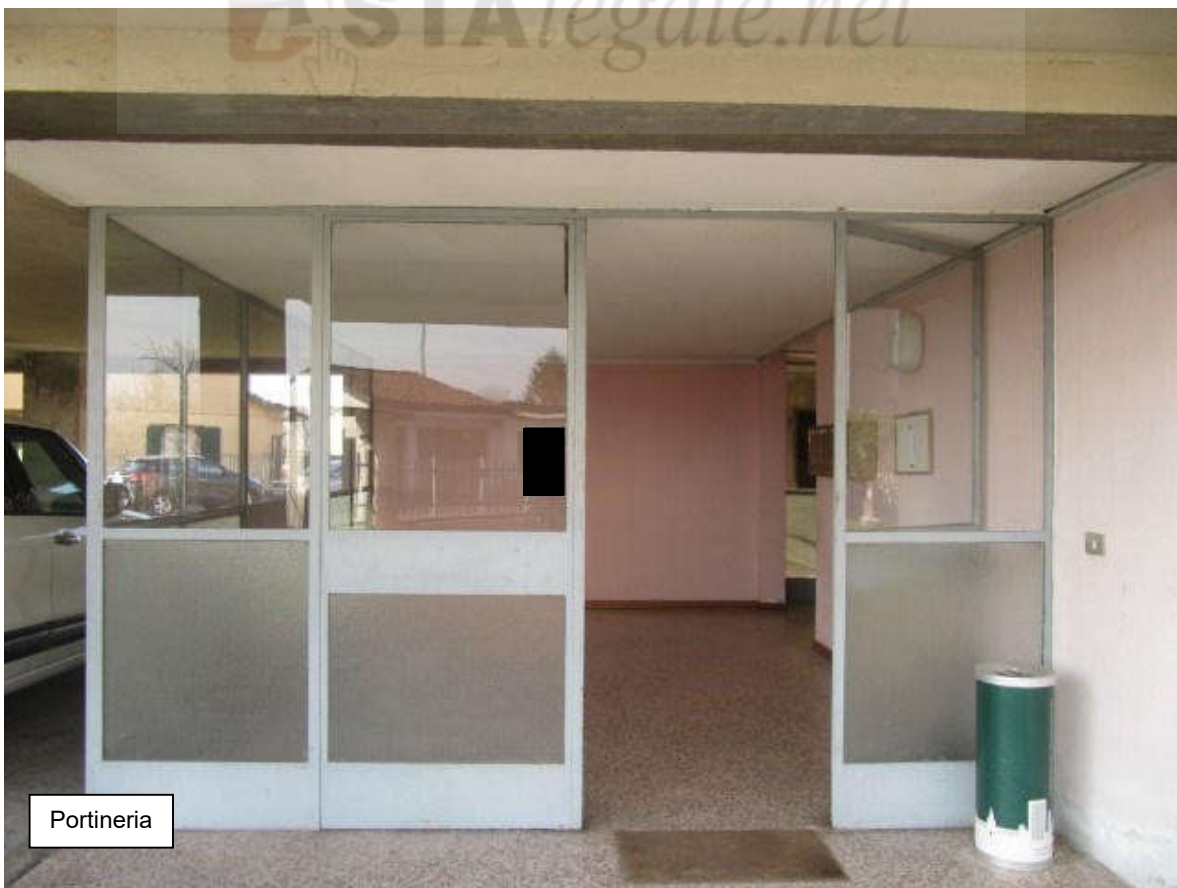
Facciata lato Ovest
