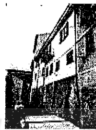
Il prospetto sud su Via Vittorio Veneto
