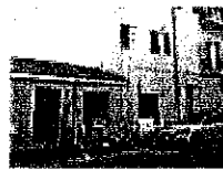
Il prospetto nord lungo la Statale n° 28
