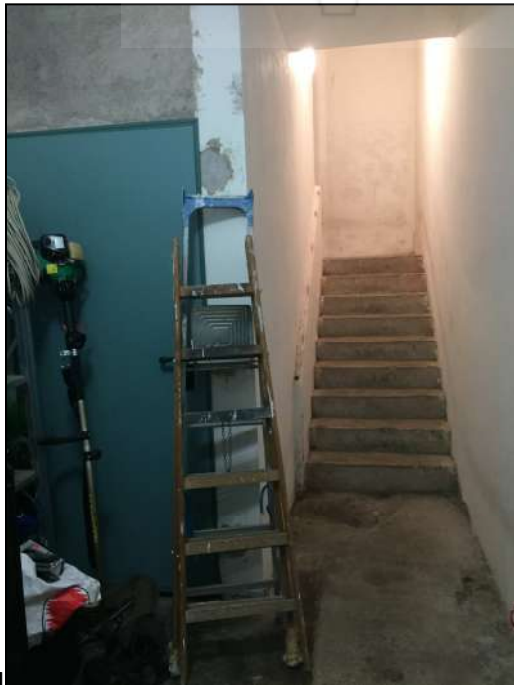
Scale interne dal piano terra al primo piano
