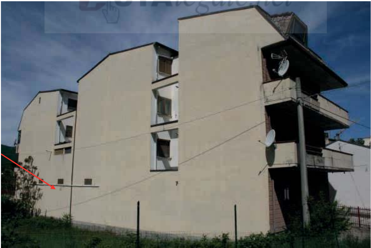
Fronte laterale– locale commerciale PT
