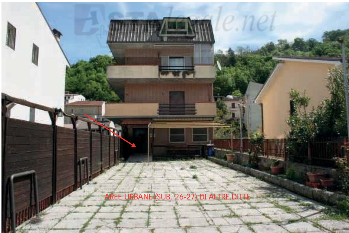
Fronte principale d'ingresso su Corso Don Giuseppe Corsetti – locale commerciale PT
