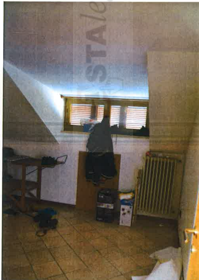
Foto n° 7: vista interna - locale bagno.
